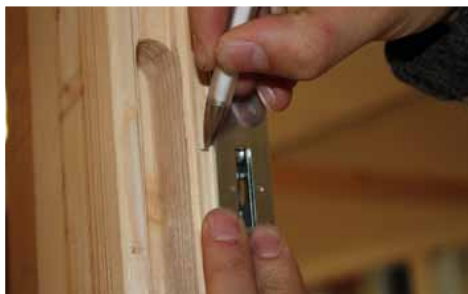
Afb. 9 Haaksparing gelijk aan afgetekende sluitplaat
