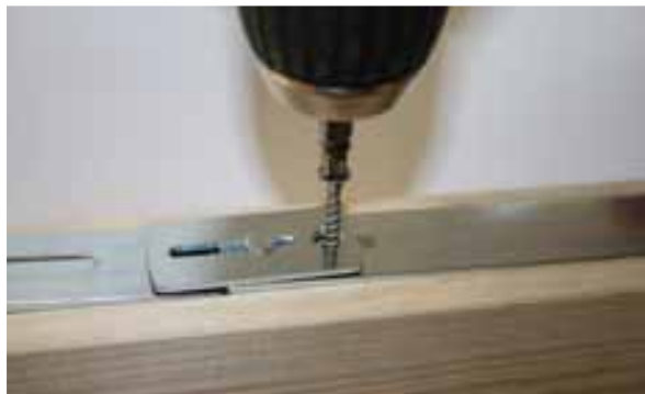
Afb. 14 Vastschroeven borgplaatje
