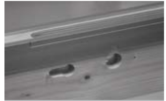
Afb. 16 Uitgefreesd kruk gat en cilindergat
