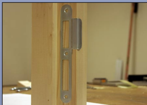
Monteer de sluitplaat in de vooraf uitgefreesde kozijnstijl.
