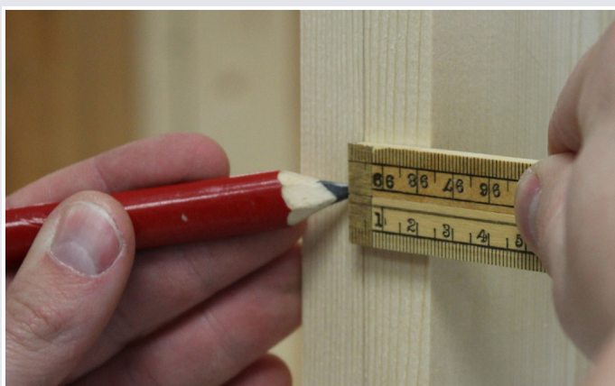
Afb. 6 Meten hart slotkast in deur
