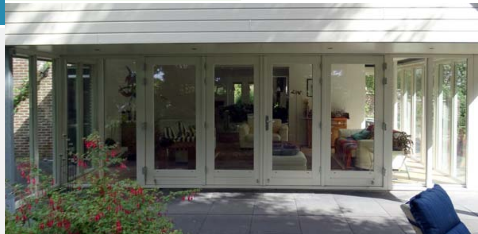
Vier deuren - met twee vaste deuren/glasvlakken
