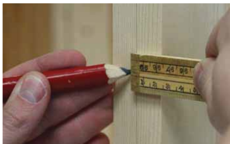
Afb. 6 Meten hart slotkast in deur
